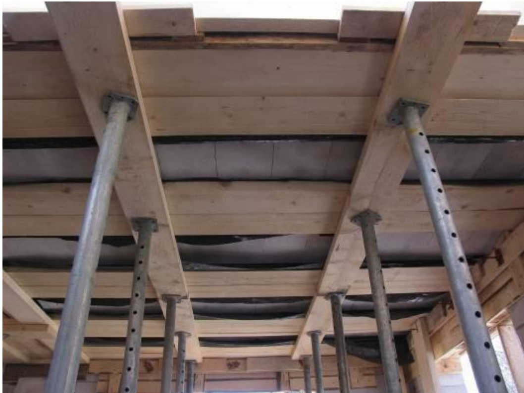
Фото 1. Применение съемной опалубки из досок
