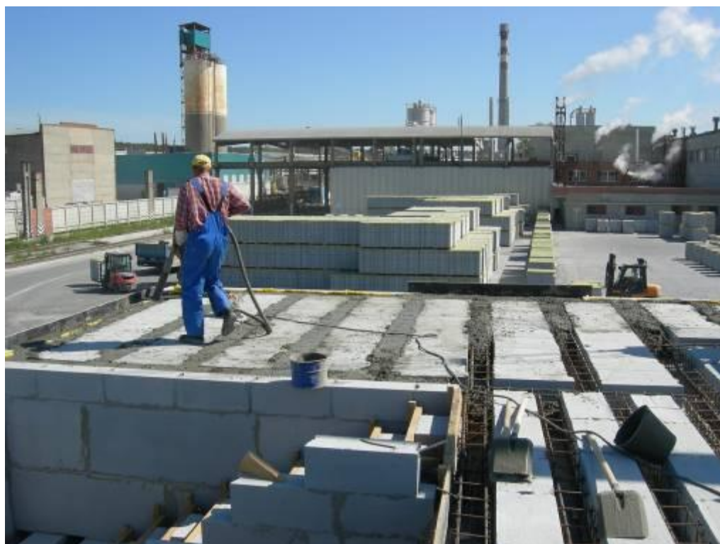
Фото 11. Бетонирование сборно-монолитного перекрытия
