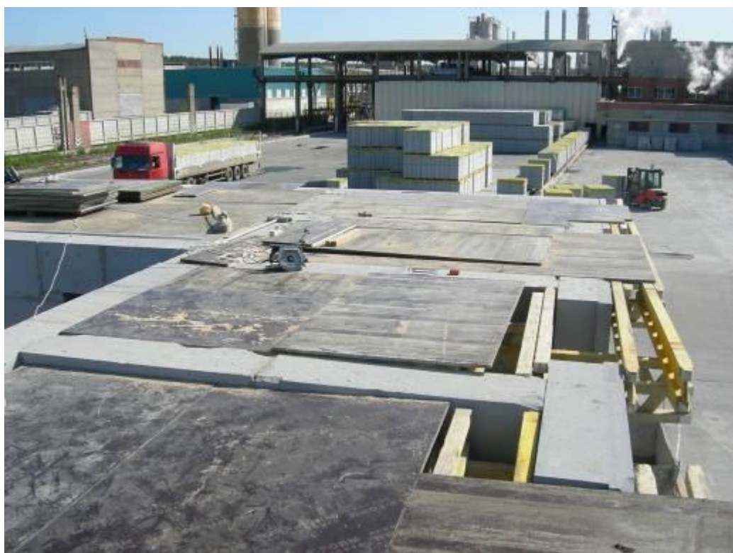
Фото 3. Укладка плит ЦСП на фермы съемной опалубки
