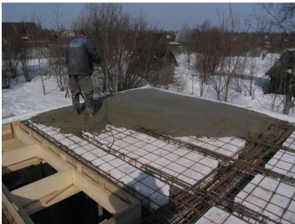
Фото 13. Устройство стяжки поверх сборно-монолитного перекрытия
