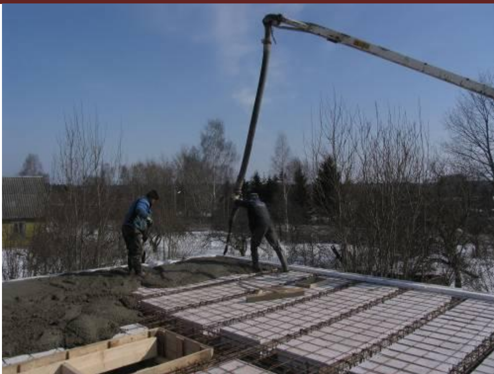
Фото 12. Бетонирование сборно-монолитного перекрытия
