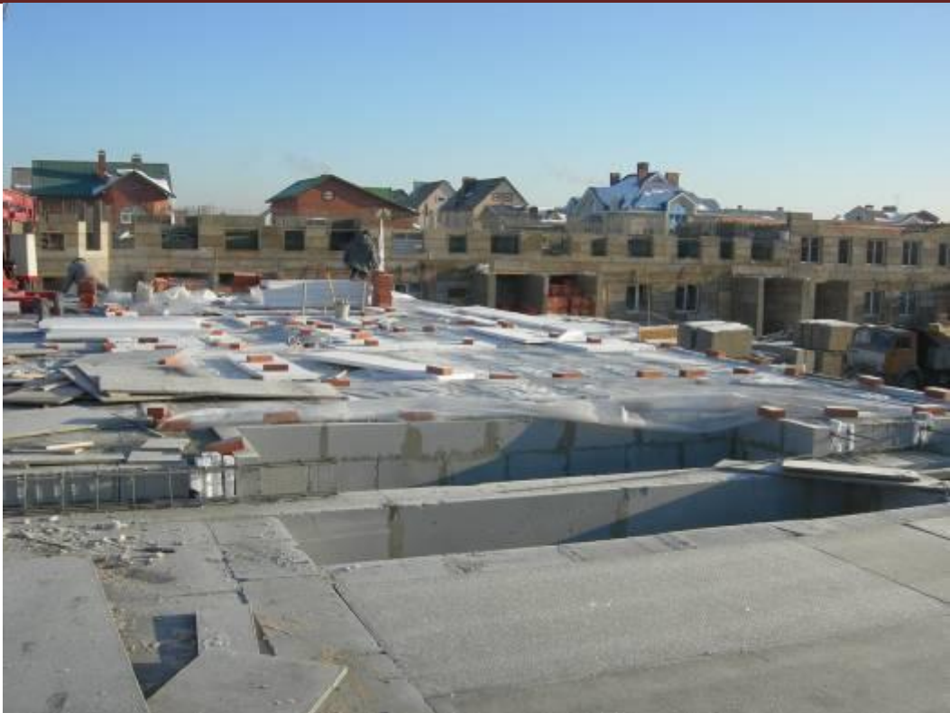
Фото 14. Устройство стяжки из плит ЦСП
