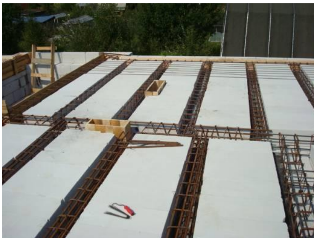
Фото 5. Этап укладки несъемной опалубки из блоков и арматурного каркаса
