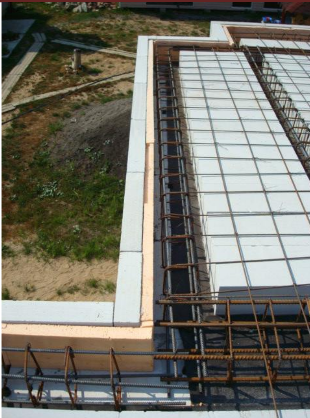
Фото 9. Устройство опалубки из твинблоков по наружному контуру перекрытия и его утепление
