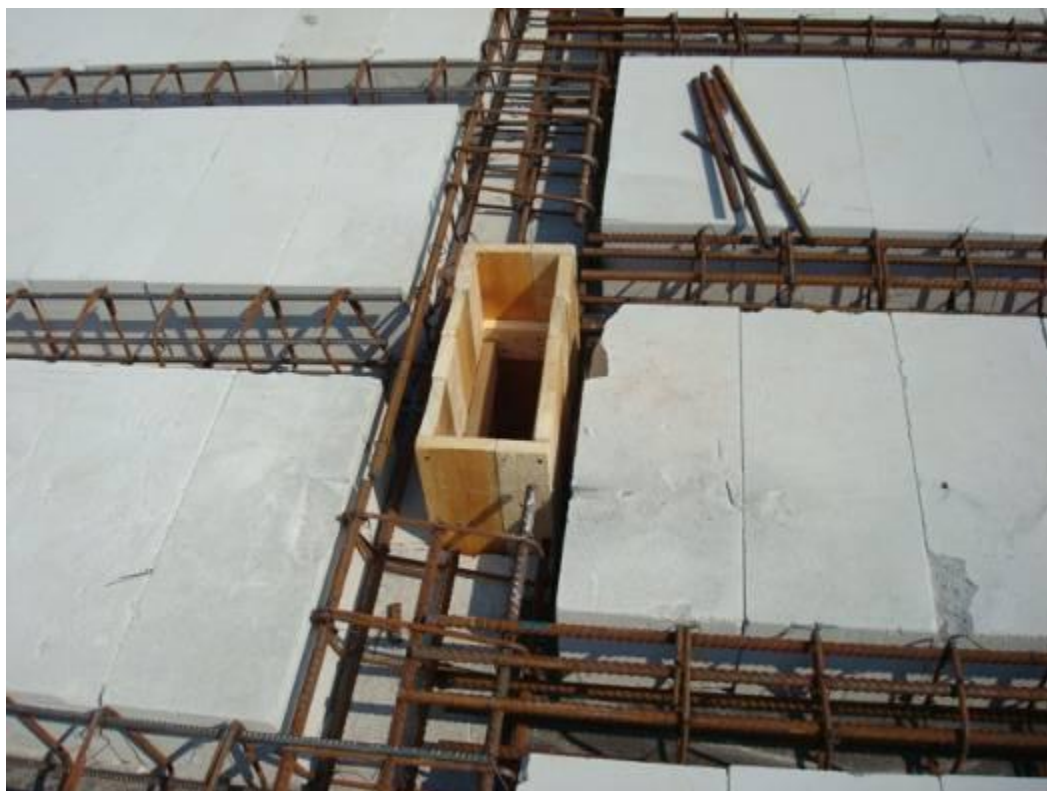
Фото 7. Устройство канала для прохода инженерных коммуникаций
