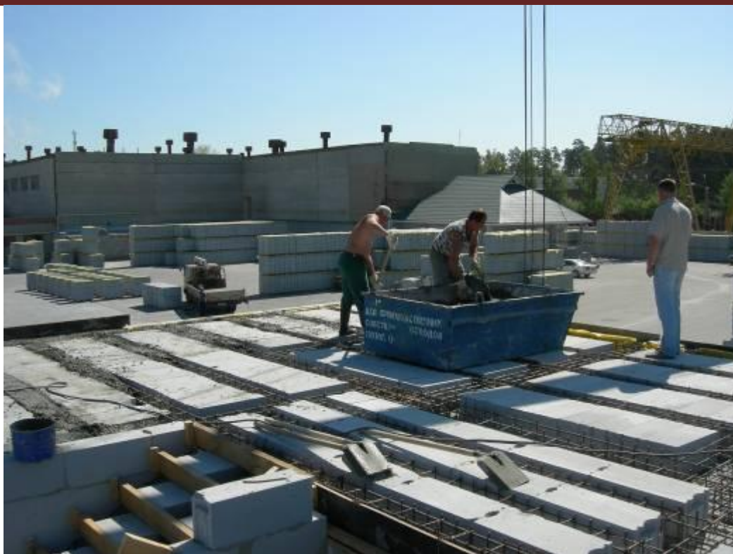
Фото 6. Подготовка перекрытия к бетонированию
