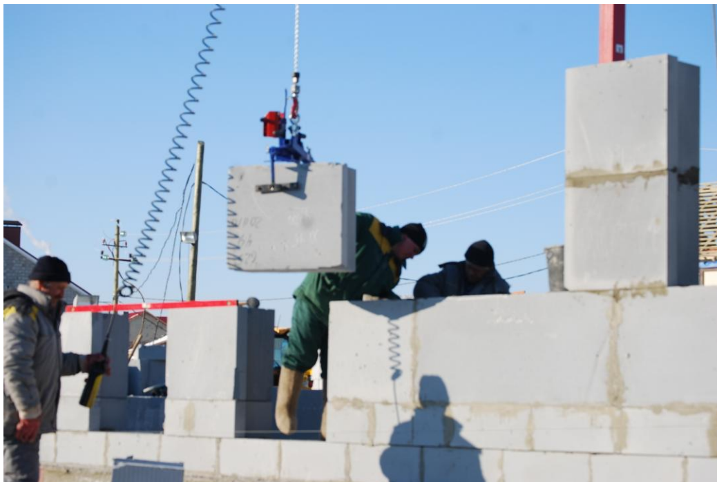
Фото 15. Монтаж укрупненных твинблоков мини краном.
