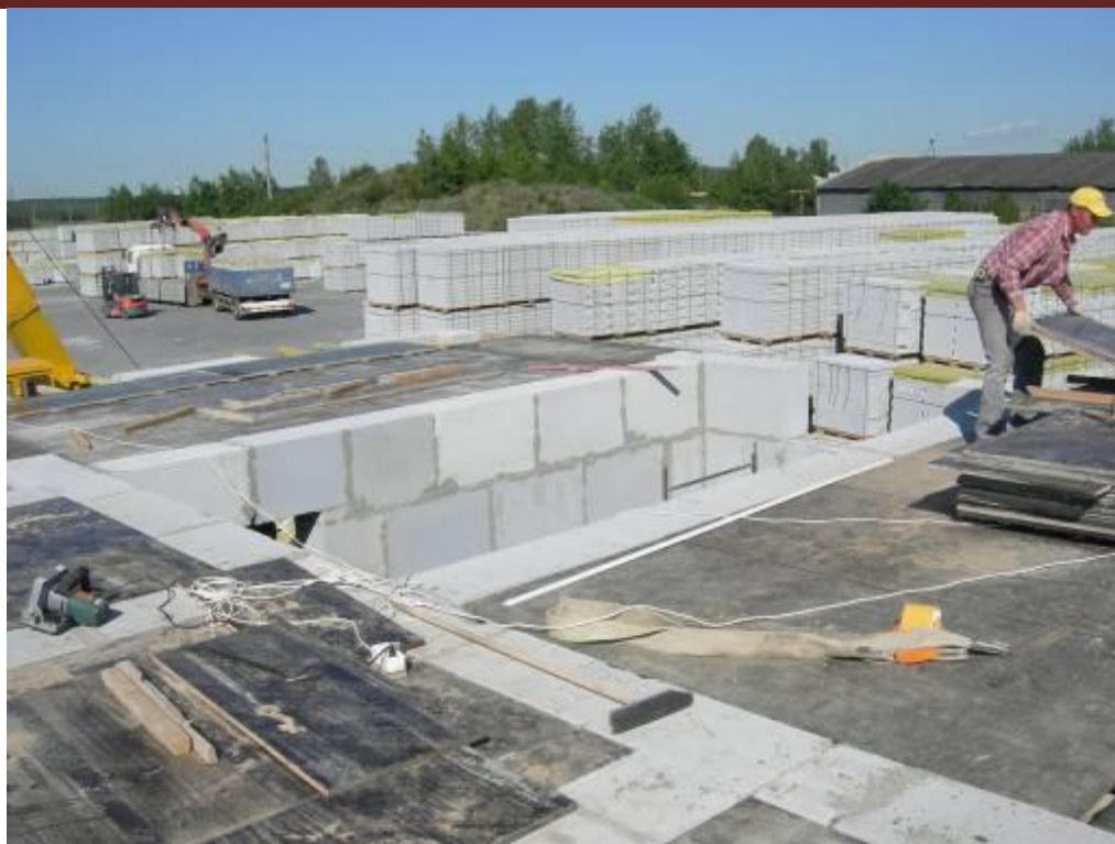
Фото 4. Вид перекрытия перед укладкой блоков рядами
