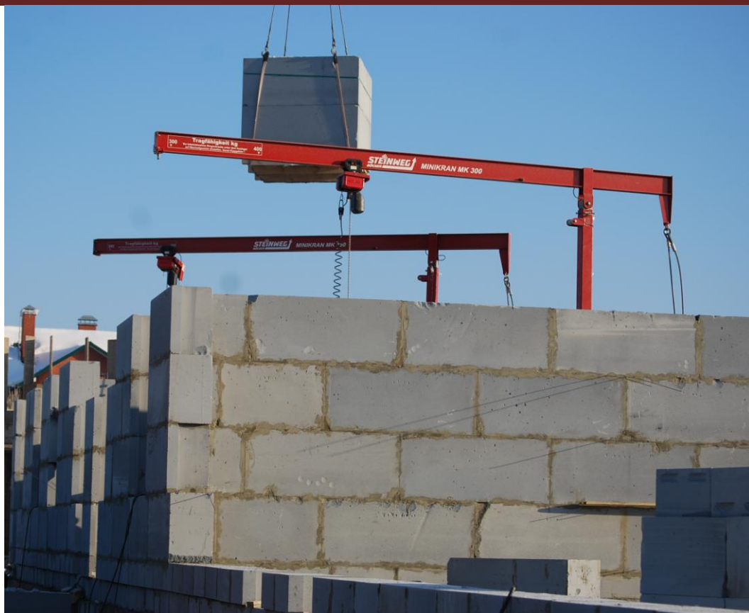
Фото 16. Установка мини кранов при монтаже укрупненных твинблоков.
