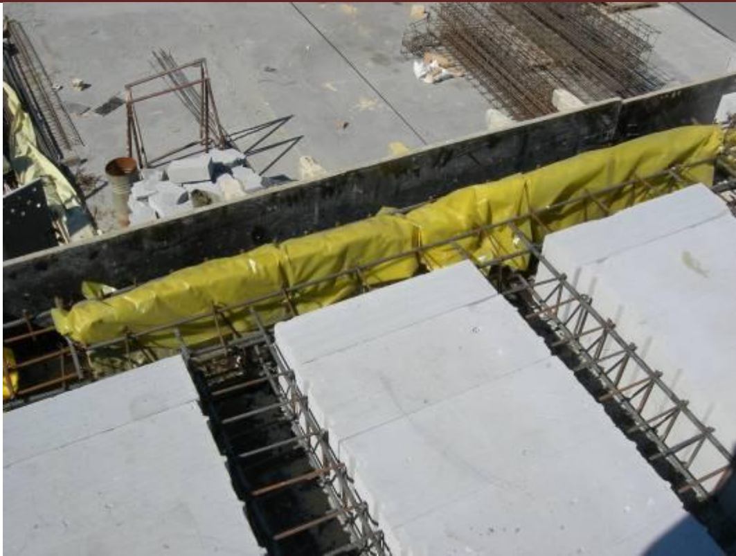
Фото 8. Устройство опалубки из плит ЦСП по наружному контуру сборно-монолитного перекрытия
