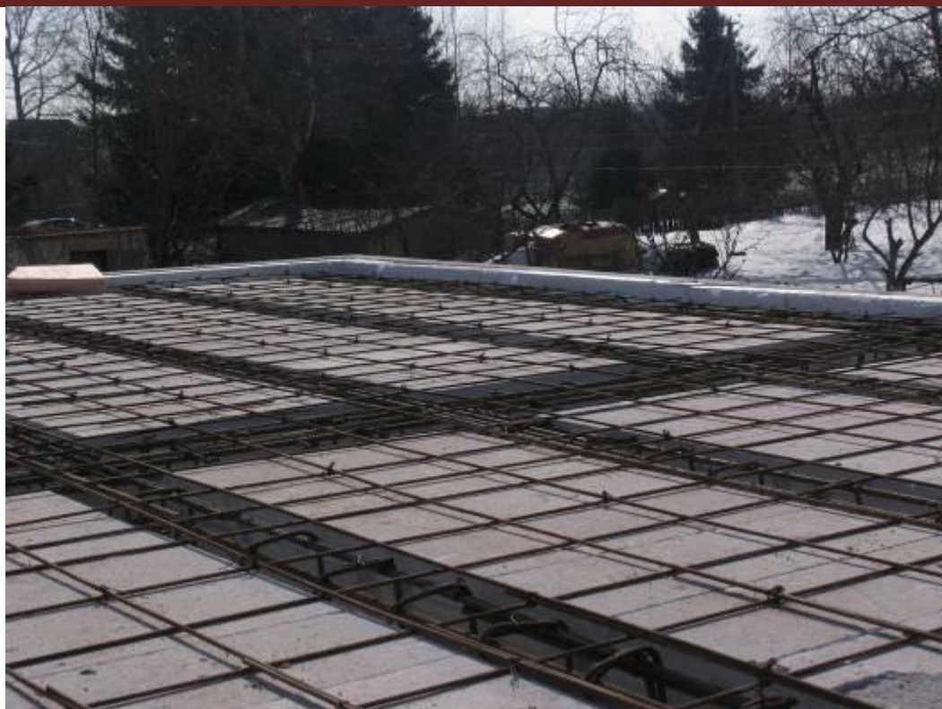
Фото 10. Укладка арматурной сетки перед бетонированием
