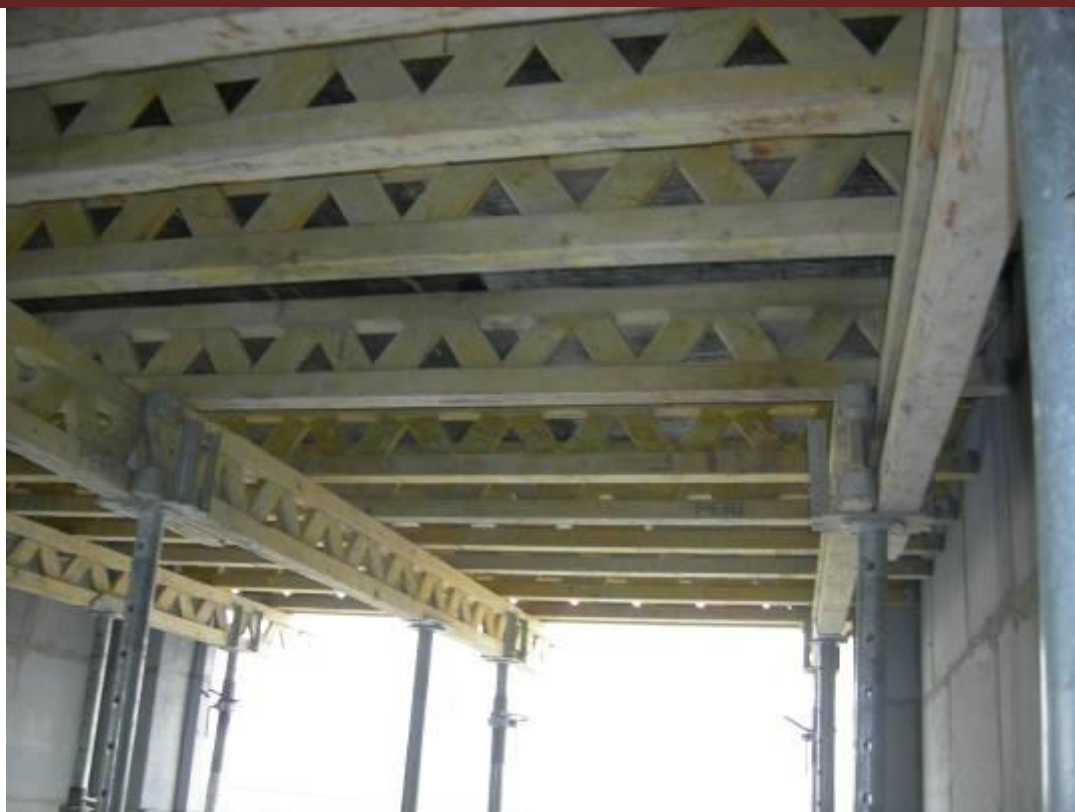
Фото 2. Применение съемной опалубки из деревянных ферм
